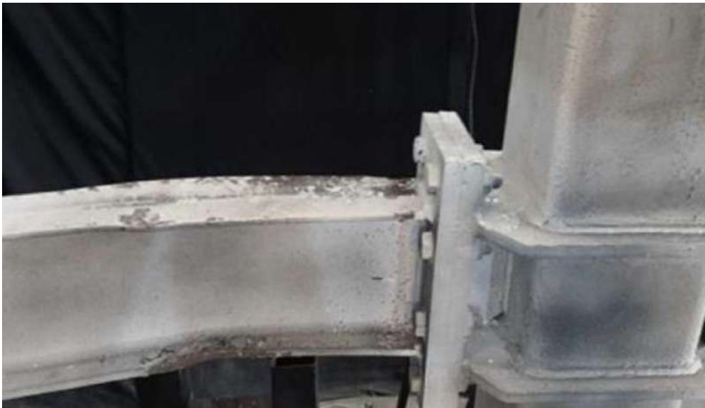
Figura 86. Daños observados en el ensayo experimental 3 de la conexión CX-2.
